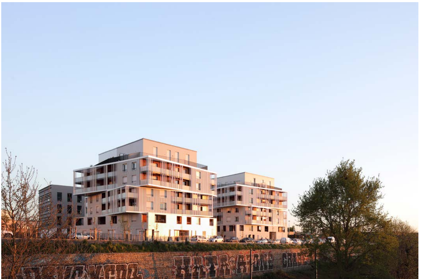
Twisty - Réalisation Groupe LAUNAY Architecte : Daquin Ferrière & Associés (93)
