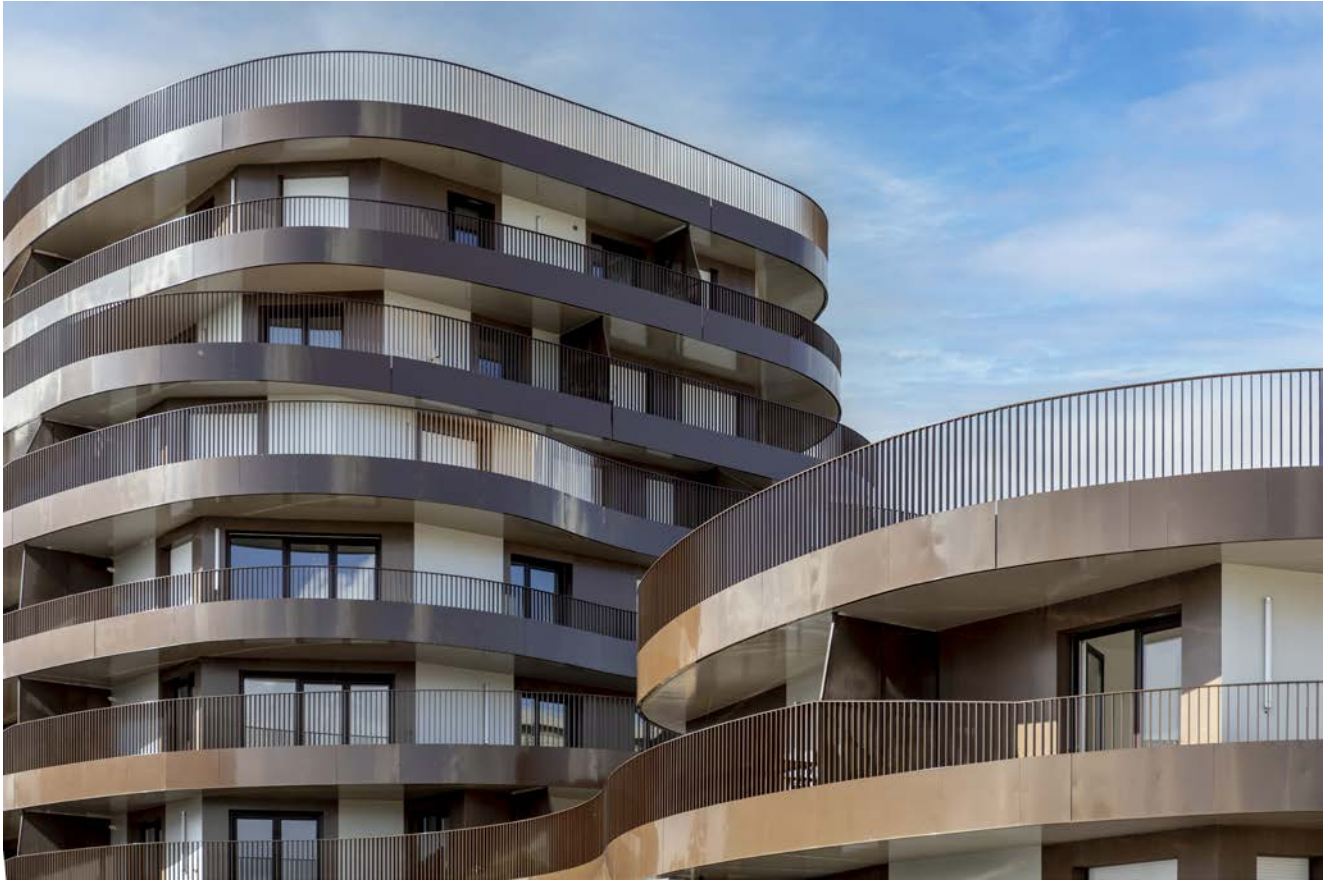
Une architecture élégante à la faveur de ses façades onduyantes
