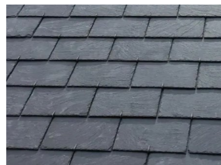
Couverture en ardoise naturelle
